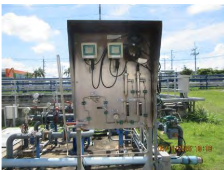
ภาพที่ 2-15 ระบบ Online Monitoring บริเวณบ่อกักน้ำทิ้งรวม
