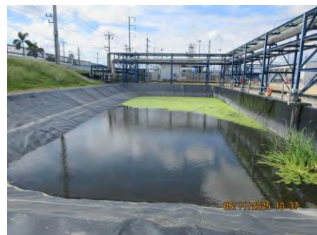
ภาพที่ 2-18 บ่อกักน้ำหล่อเย็น กรณีฉุกเฉิน
