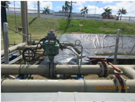
ภาพที่ 2-19 วาล์วควบคุมการปล่อยน้ำทิ้งจากหอล้อยเย็น
