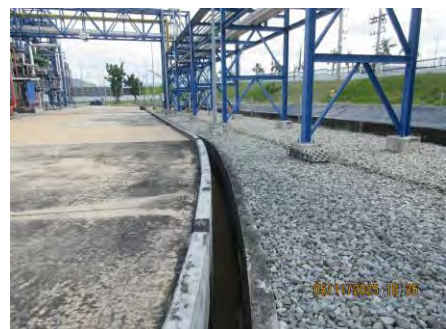
ภาพที่ 2-30 รางระบายน้ำฝนในพื้นที่โครงการ
