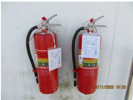
ภาพที่ 2-41 การตรวจสอบอุปกรณ์ดับเพลิง
