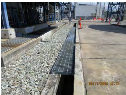
ภาพที่ 2-30 รางระบายน้ำฝนในพื้นที่โครงการ
