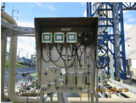
ภาพที่ 2-17 ระบบ Online Monitoring บริเวณบ่อกักน้ำหล่อเย็น
