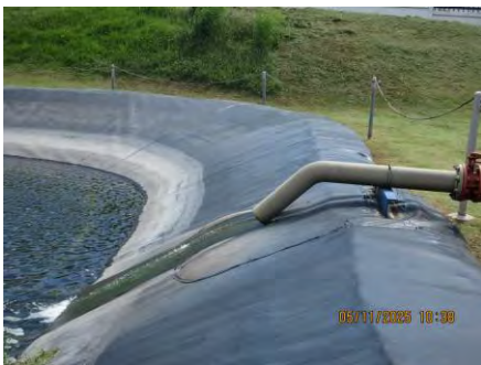
ภาพที่ 2-21 ระบบกระจายน้ำที่บริเวณจุดปล่อยน้ำทิ้ง
